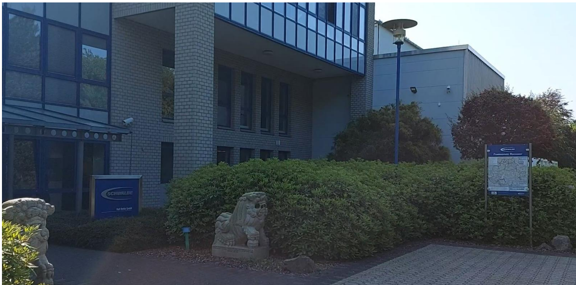
Vorhandener westlicher Gebäudebestand
