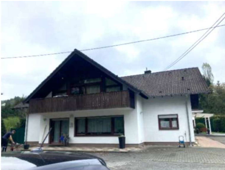
Abbildung 3: Bestandsgebäude mit Freileitungen der Deutschen Telekom (Quelle: Mestermann)
