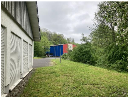
Abb. 6 Rasenfläche östlich des Gebäudes.
