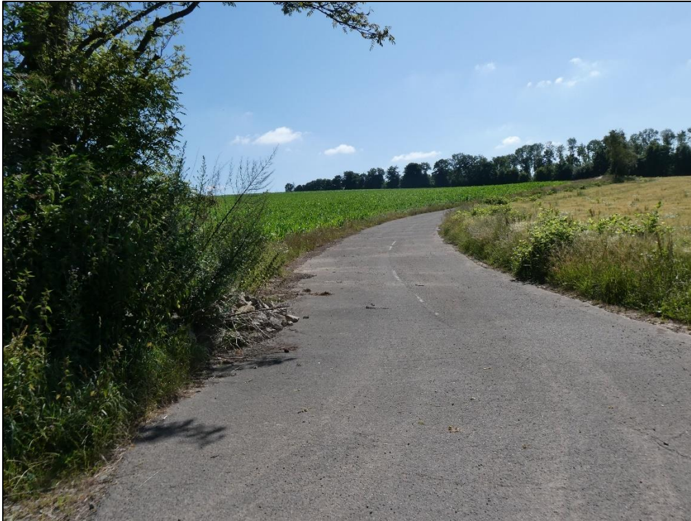
Abb. 6: Asphaltierter Weg im Süden des Plangebietes.
