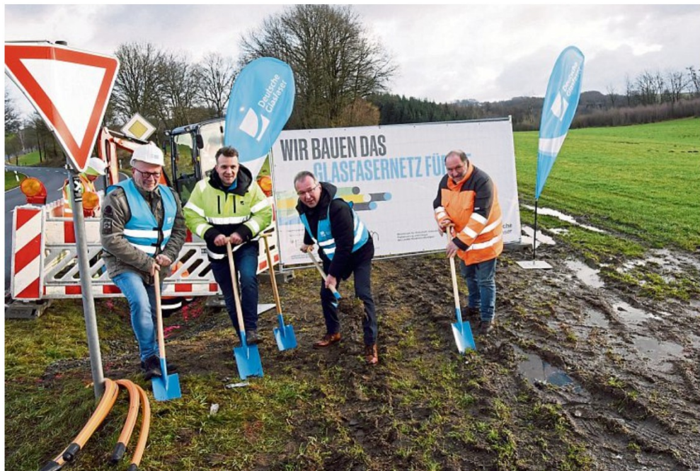
Die ersten sechs Kilometer Leerrohr sind schon verlegt. Den symbolischen Baustart holte Projektleiter Thomas Bilski (2. v. l.) jetzt nach mit den Gemeindevertretern (v. r.) Norbert Schindler, Rüdiger Gennies und Jürgen Seynsche. Foto: Dierke
