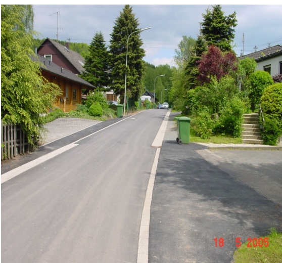
Quelle: Tiefbauabteilung, Ansicht einer Straße nach qualifiziertem Aufbau mit Beleuchtungs- und Entwässerungseinrichtung
